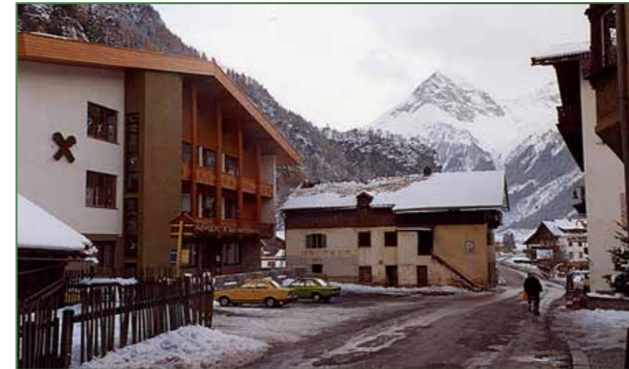
1979 wurde der Komplex bzw. das alte Postamtsgebäude abgerissen und das neue Mehrzweckhaus gebaut.
